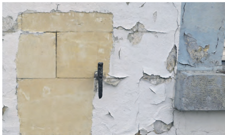
Het inschakelen van een specialist loonde. Alleen de mergelbouwer kreeg de verf in één arbeidsgang volledig verwijderd
