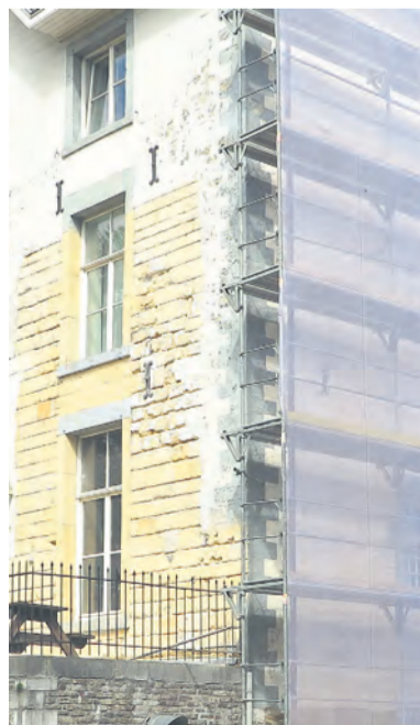
De verschillende fases van schilderen zijn goed zichtbaar: verf verwijderen, repareren en opnieuw voegen
