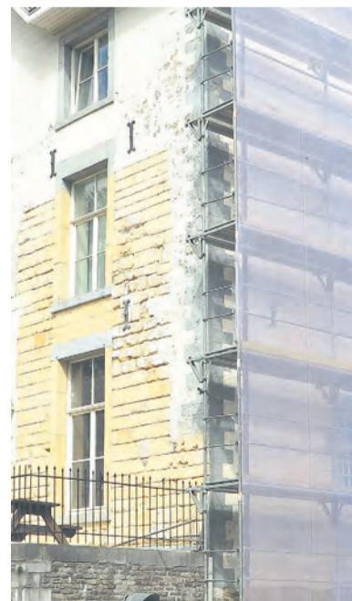
De verschillende fases van schilderen zijn goed zichtbaar: verf verwijderen, repareren en opnieuw voegen
