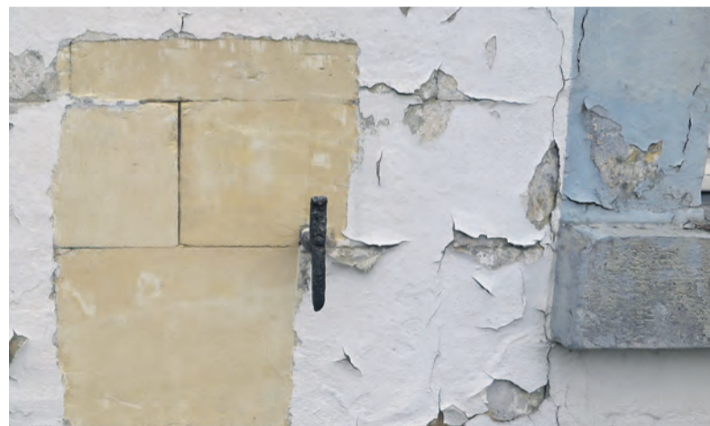
Het inschakelen van een specialist loonde. Alleen de mergelbouwer kreeg de verf in één arbeidsgang volledig verwijderd
